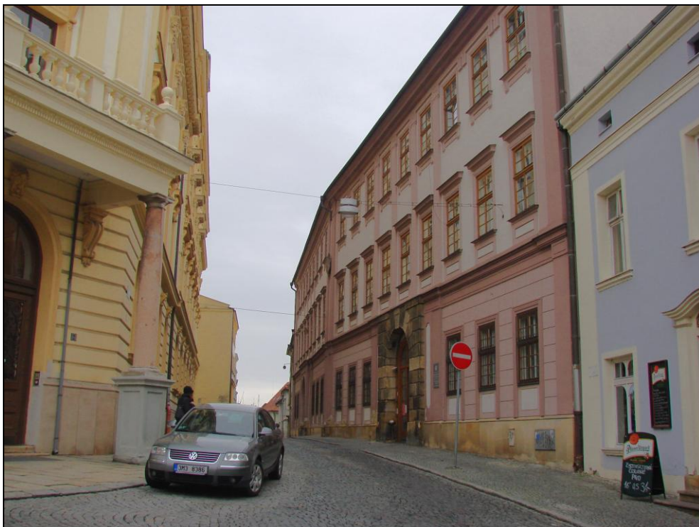
Obr. 13. Výukový objekt na ul. Purkrabská.
